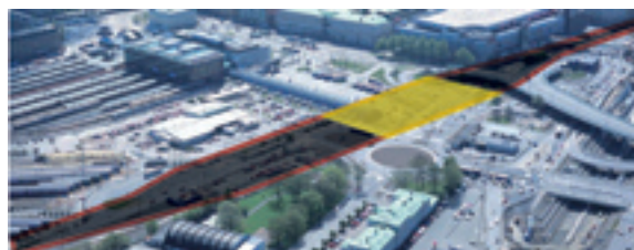
Flygbilden till höger visar schakt- och etableringsområde norr om Göteborg Central. Det gula området visar vilket område som kan komma att användas för överbyggningar under de olika byggetapperna.
